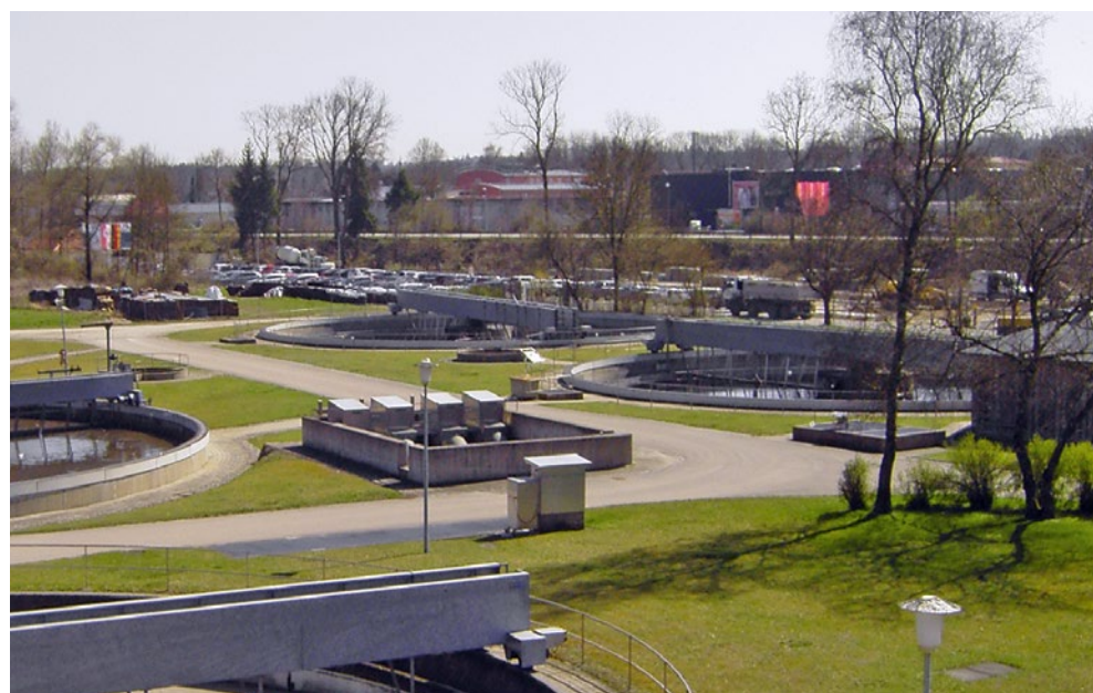
Bildmitte: Zwischenhebewerk, dahinter Nachklärbecken 1 und 2
