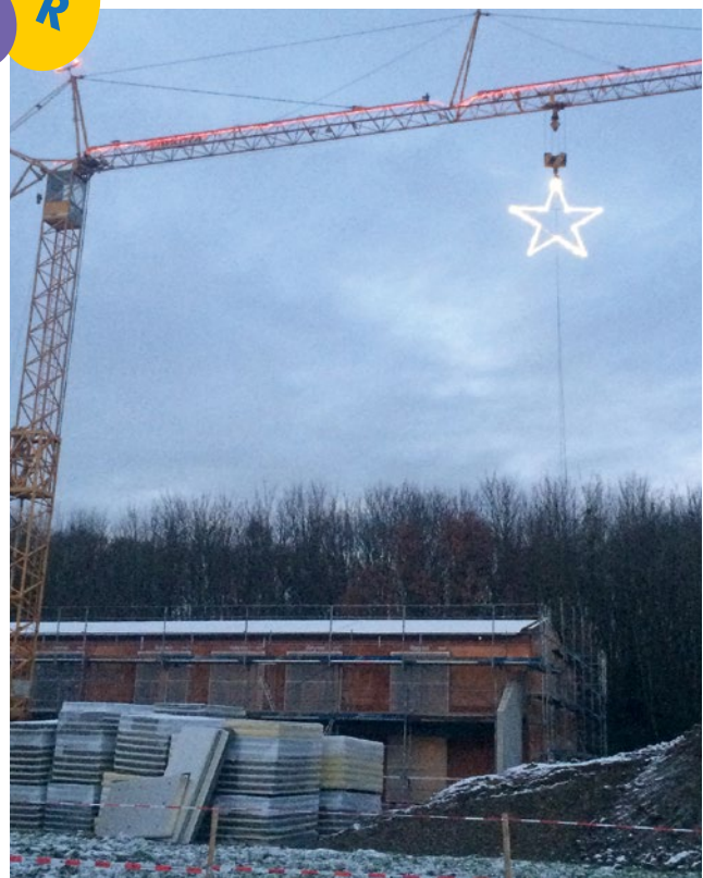
Ein Stern leuchtete über dem Rohbau der Kinderkrippe.
