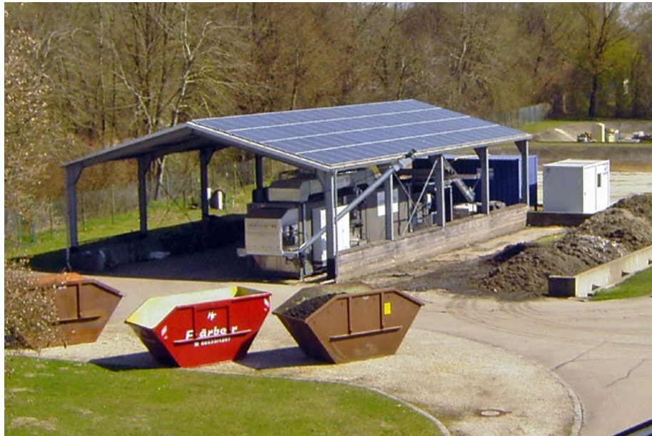
Halle für Schlammbehandlung mit Trocknung und Entwässerungszentrifuge (rechts)
