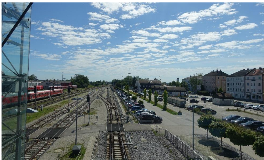
Bahnanlagen, Foto: Plankreis
