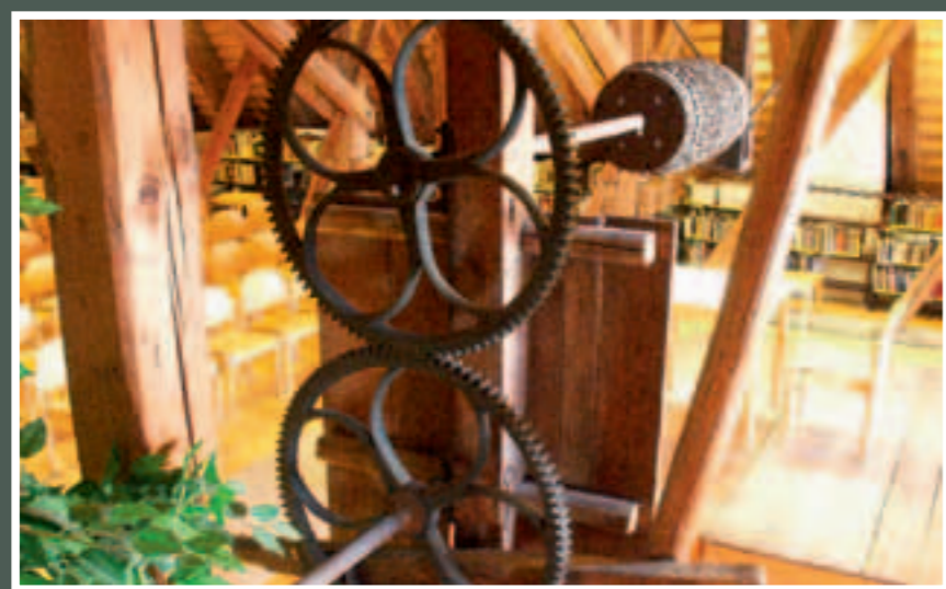
Historischer Lastenaufzug (Teilansicht)
