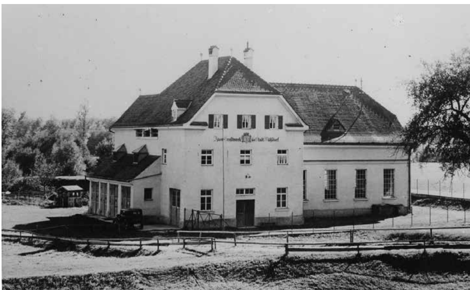
Isenkraftwerk der Stadt Mühldorf
