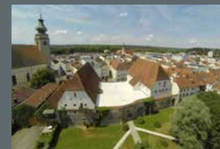
Haberkasten Innenhof (überdacht)
