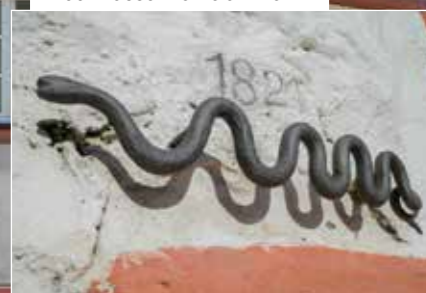
Hochwasserlinie am Turm
